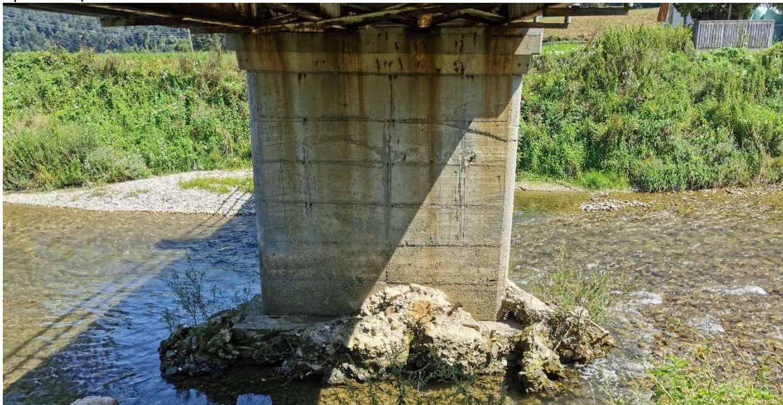
Slika 4 - Pogled na erodiran temelj levega opornika
