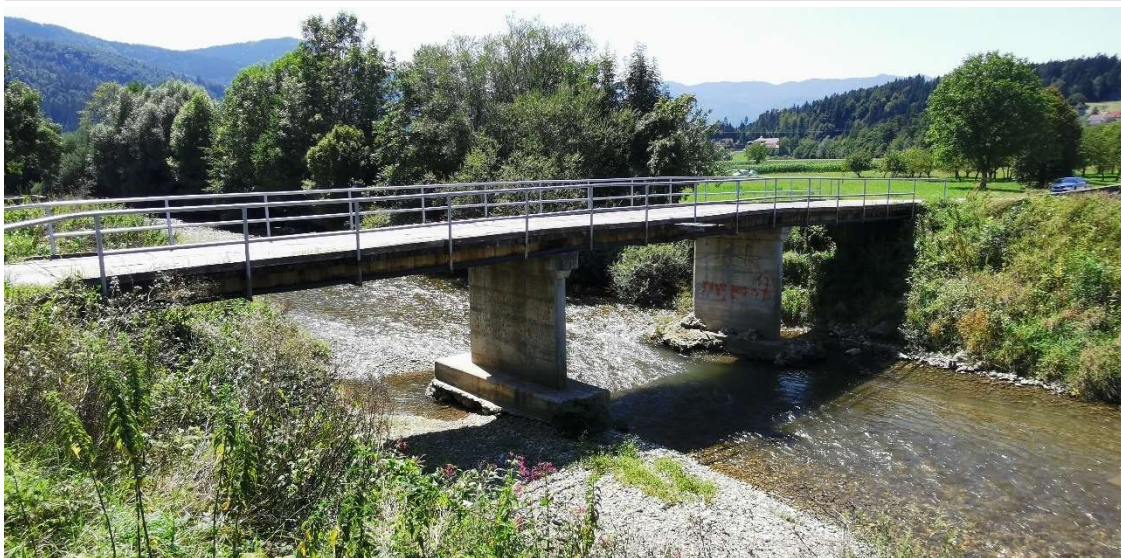
Slika 3 - Pogled na most gorvodno z desne brežine (jasno razvidni erodirani temelji sredinskih opornikov)
